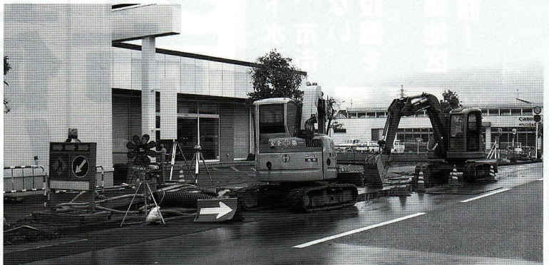
下水道工事(福井市下馬中央公園前:1月)
