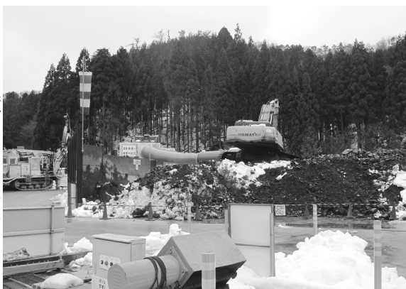
奥野々工区作業入口
